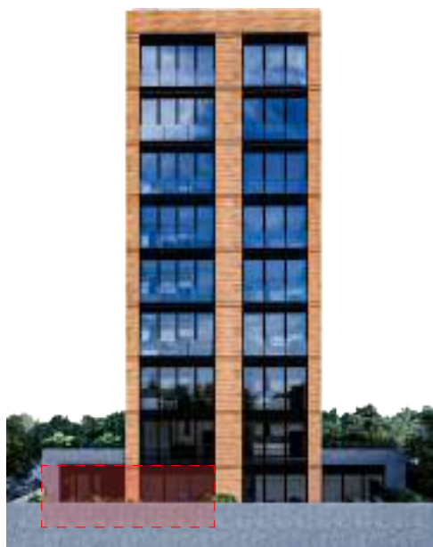
Ubicación en fachada
